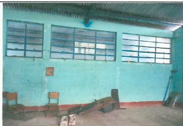
Foto 3: VENTANAS Y PUERTAS EN AULA 2
