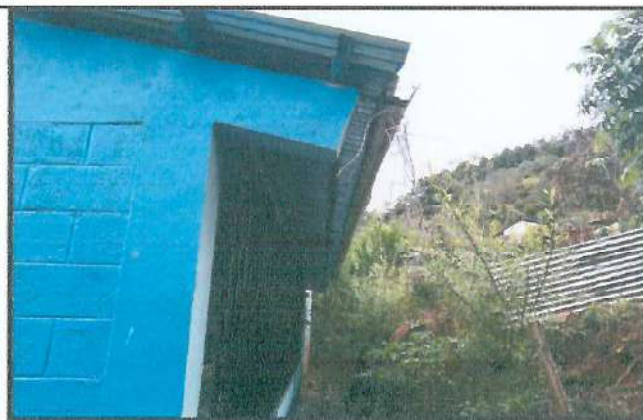
Foto 4: CANALES Y BAJADAS DE AGUA PLUVIAL
