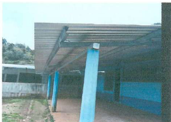
Foto 1: CANALES Y BAJADAS DE AGUA PLUVIAL
